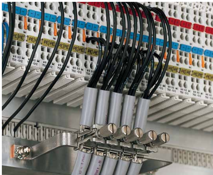
Abbildung 20: Anwendung des WAGO-Schirm-Anschlussystems
